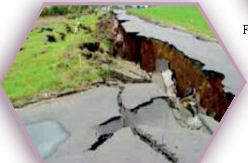
Ruptures superficielles sous forme de fissures ou étalement latéral
