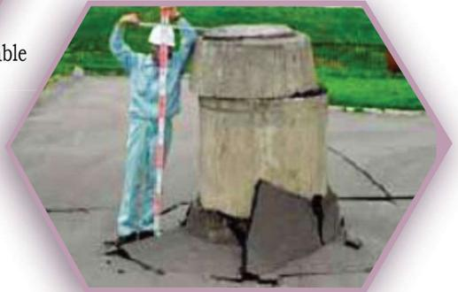
Soulèvement des ouvrages enterrés et rupture des canalisations
